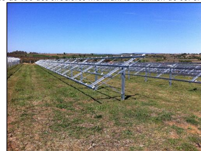
Illustration 15 : Exemple de vue des structures montrant le maintien du sol et de la végétation herbacée
