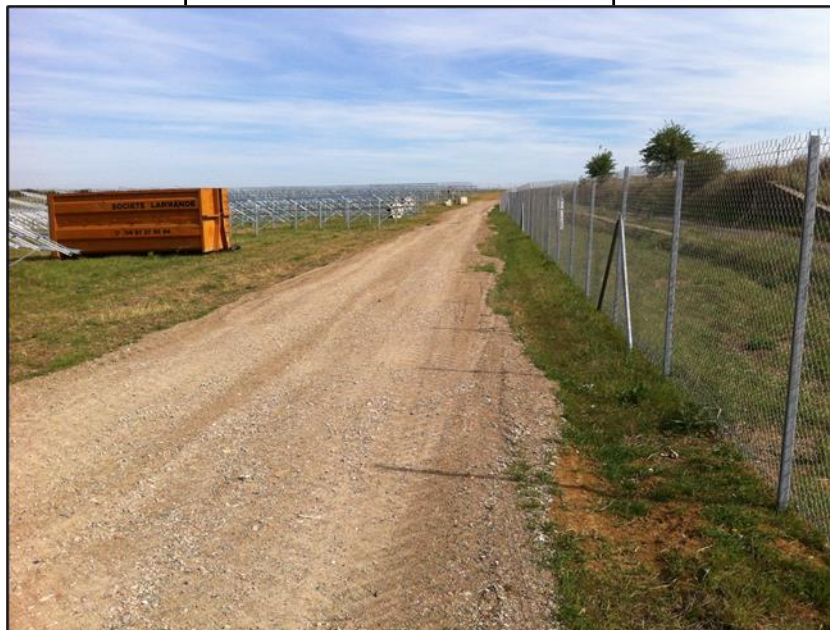
Illustration 21 : Exemple d'une bande de roulement adaptée aux véhicules lourds
