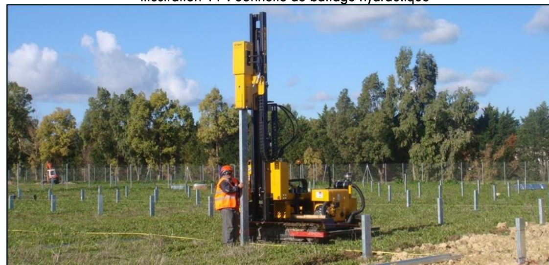
Illustration 11 : Sonnette de battage hydraulique
